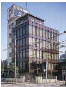
第二ビル別館
