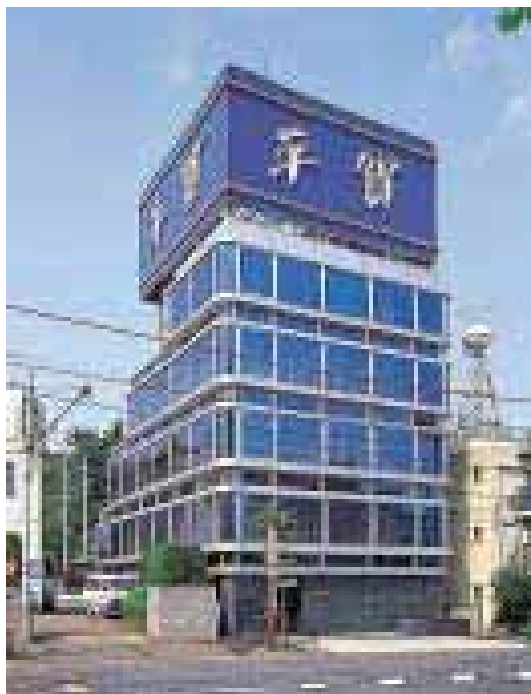
東京都練馬区 本社ビル
