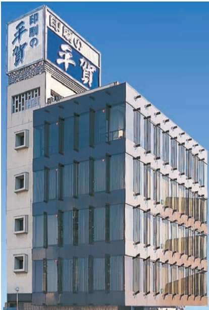
第二ビル(別館)
