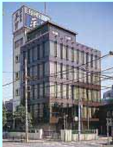
第二ビル別館
