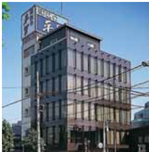
第二ビル：別館
