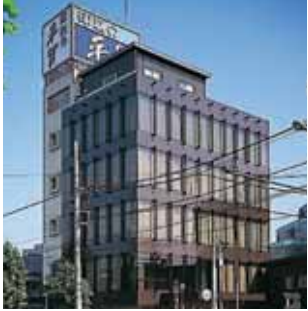
第二ビル：別館
