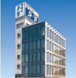
第二ビル：別館
