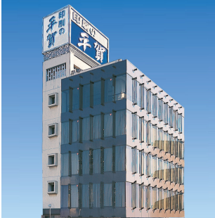
第二ビル(別館)
