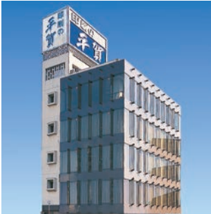
第二ビル(別館)
