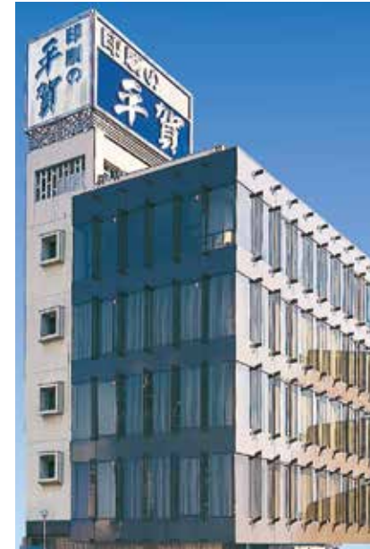
第二ビル(別館)
